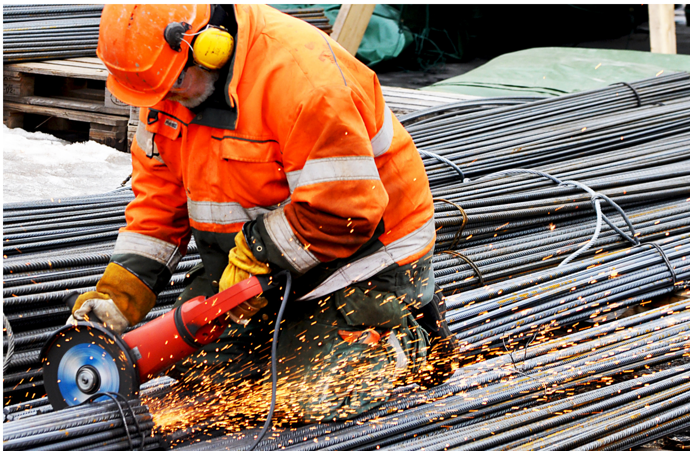
Elektrisk och mekanisk utrustning som ska användas inom FKA ska besiktigas före intransport.
